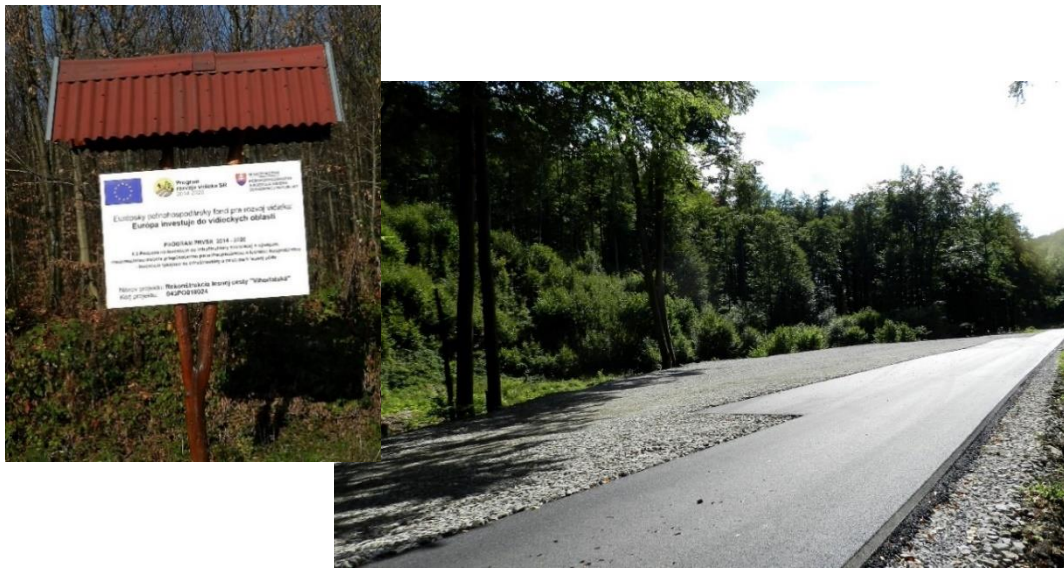
Obrázok 1 a 2 Rekonštrukcia LC Vihorlatská
